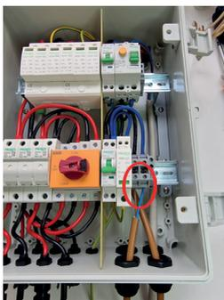
3. Questo cavo non deve avere la terra, e va collegato alla uscita del contatore di produzione. Se il contatore non è ancora presente, si suggerisce di predisporre uno spezzone di cavo di lunghezza opportuna.
