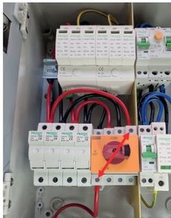
2. Prendere il secondo cavetto rosso, montarlo nel foro DC OUT / +2 e collegarlo al terzo terminale da sinistra del sezionatore rotativo DC. Notare come il sezionatore rotativo ponga in corrispondenza i contatti posti alle diverse profondità delle morsettiere, quindi di fatto come se fossero collegati da un ipotetico diametro tracciato per il centro del sezionatore.
