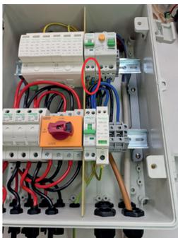
3. Questo cavo non deve avere la terra, e va collegato alla basetta del contatore di produzione. Se la basetta non è ancora presente, si suggerisce di predisporre uno spezzone di cavo di lunghezza opportuna.
