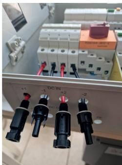
4. Utilizzare i connettori fotovoltaici volanti forniti nel sacchetto IN per terminare dalla parte di questo quadro i cavi di collegamento provenienti
